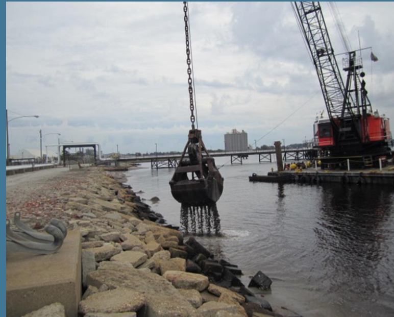
First subaqueous sand cap in VA
